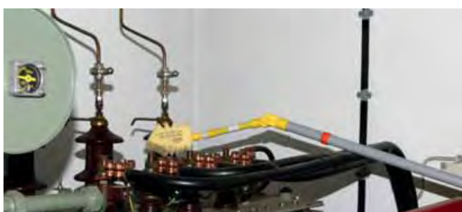
KöF kombinált tisztítókészlet transzformátor feszültség alatti száraz és nedves tisztításához
